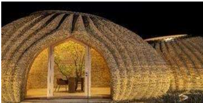
3D baskılı kil evler - Modern yapıya sahip geleneksel malzemeler TECLA, Massa Lombarda, İtalya
